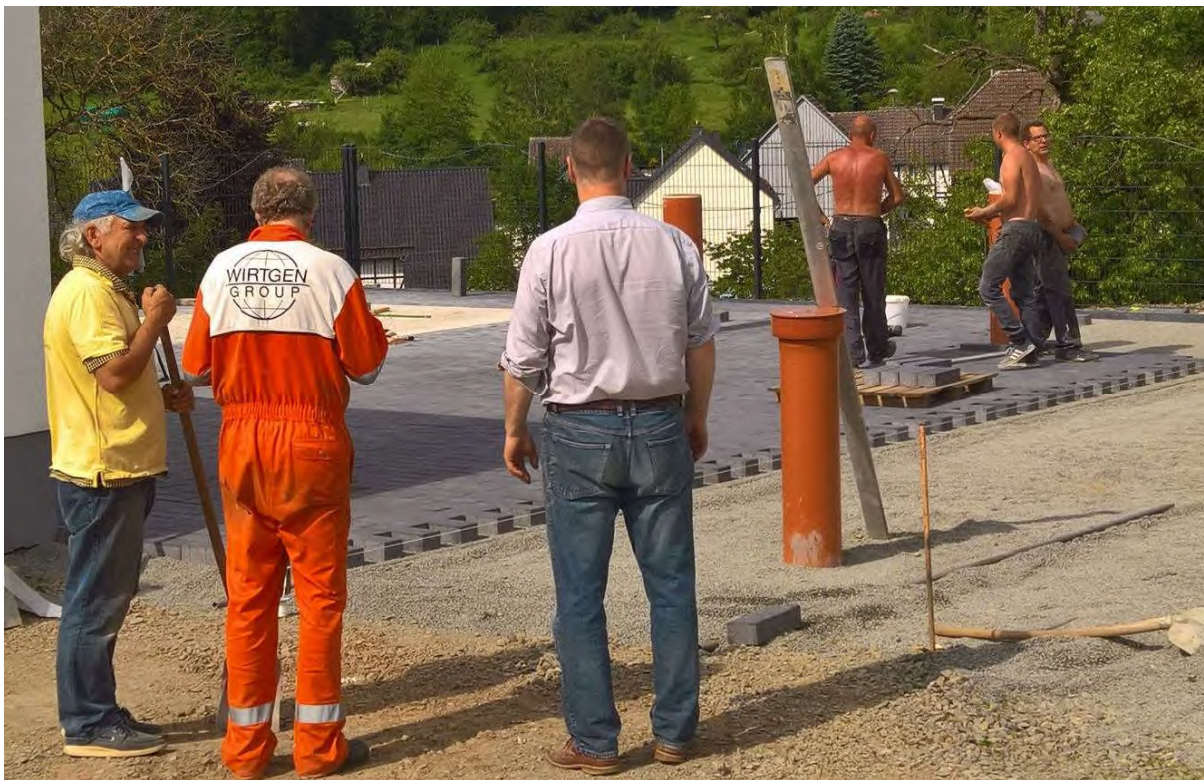
Das Pflaster wird verlegt. Links Wojciech Walczak.
