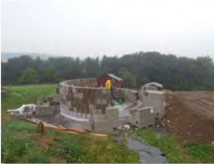
Bau des Turmuntergeschoßes.
