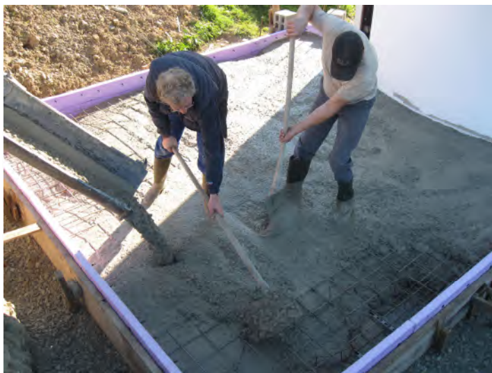
Damian verlegt Belüftungsrohre. Klaus und Kai Müller gießen das Flurfundament.
