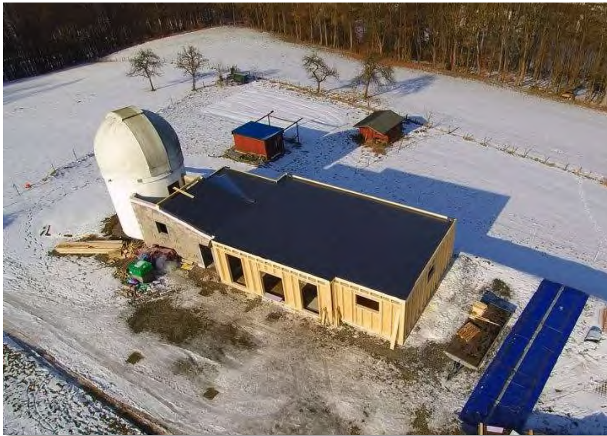
Aufnahme des Rohbaus aus Damians Drohnenfilm.
