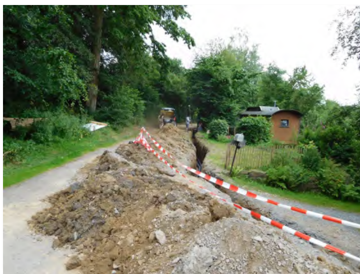
Bau des Versorgungskanals.
