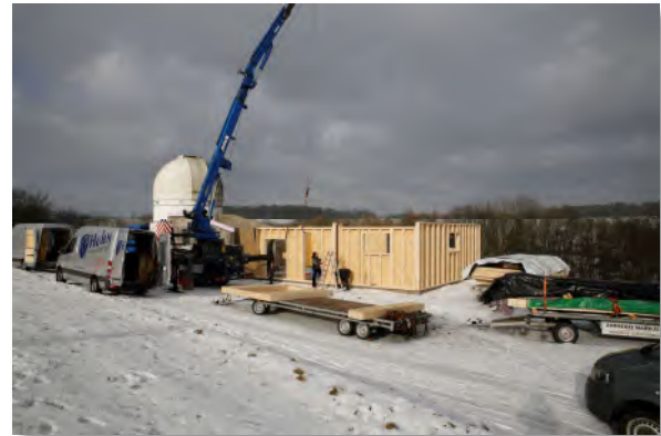
Aufbau des Servicegebäudes.
