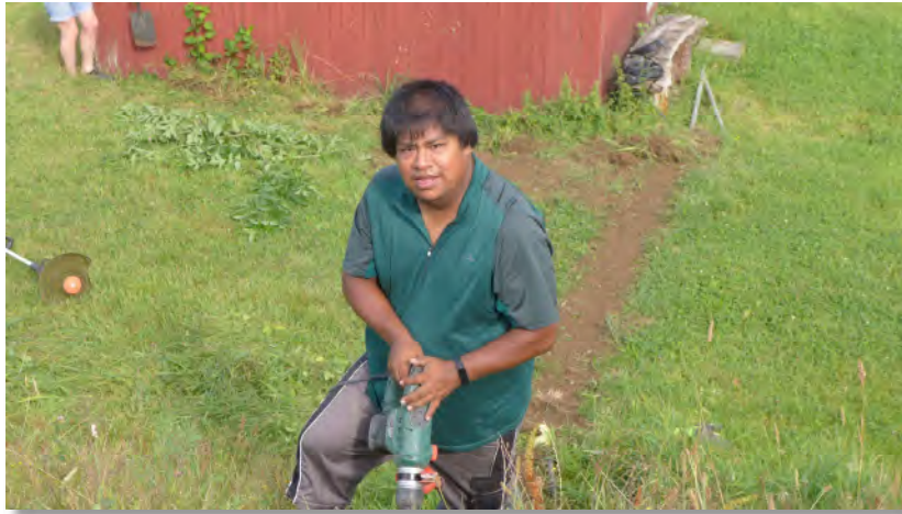
Johannes Stinner im Tiefbau.
