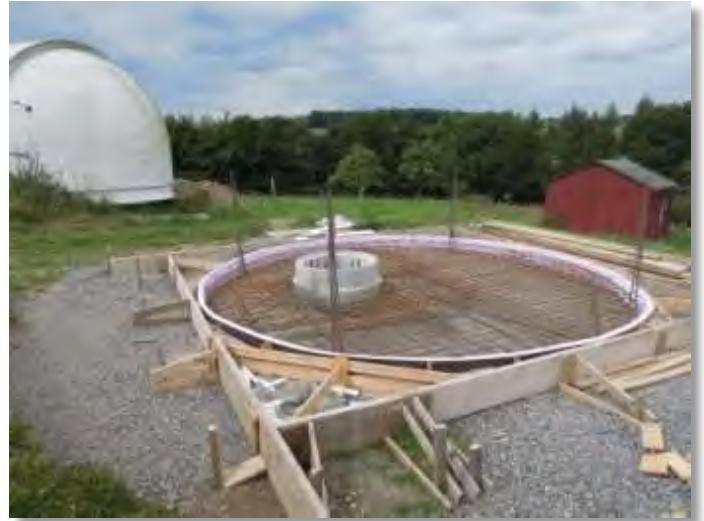
Bau des Turmuntergeschoßes.
