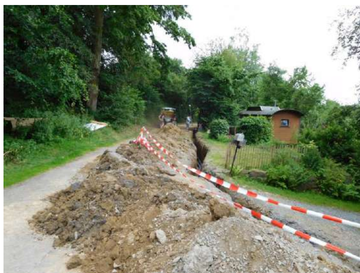
Bau des Versorgungskanals.
